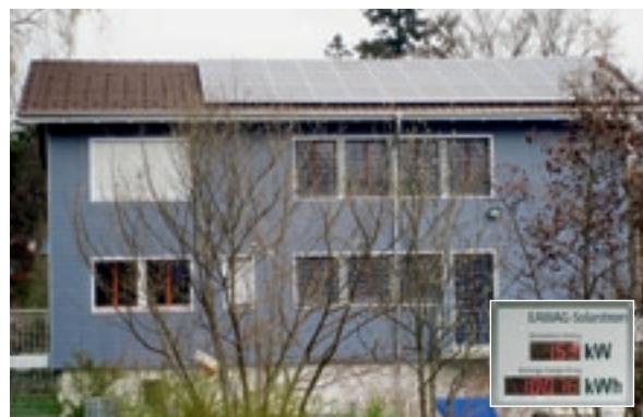
Die Fotovoltaikanlage auf dem renovierten Bootshaus in Kastanienbaum hat bereits mehr als 10000 kWh Strom geliefert. Sie wurde mit CO 2 -Abgaben aus Flugreisen finanziert.
