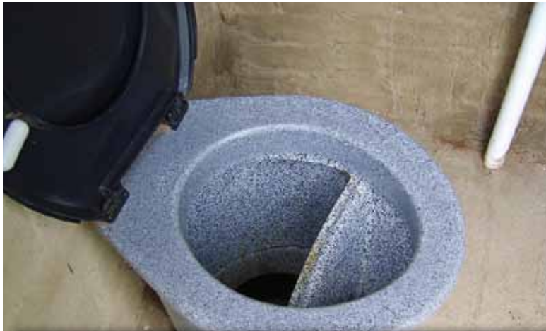
Trockentoilette mit Urinseparierung in Südafrika und ein Wirbelbettreaktor zur Urinbehandlung. Toilette sèche à séparation d'urine en Afrique du Sud - Traitement de l'urine sur lit fluidisé. A urine-diverting dry toilet in South Africa and a moving bed biofilm reactor for urine treatment.
