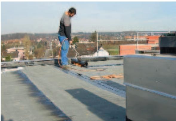
Abdichten eines später extensiv begrünten Flachdachs mit wurzelfesten Bitumenbahnen.
