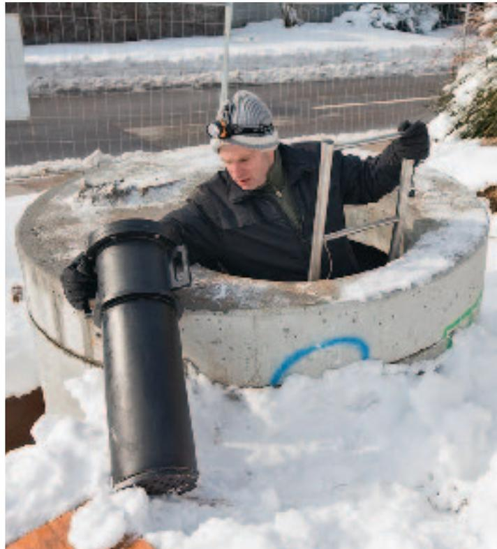
In diesem Schacht wird das Dachabwasser einer neuen Überbauung gesammelt, deren Dächer mit Kupferblech gedeckt sind. Zwölf mit Granulat gefüllte Filterpatronen können einzeln ausgewechselt werden. Sie reinigen das Wasser, bevor es in einen kleinen Bach geleitet wird.
