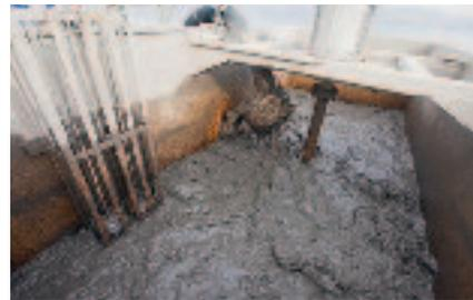
Auf dem Ponton gelangt der Schlamm in ein Pufferbecken und wird von dort an Land zur Aufbereitung gepumpt.
