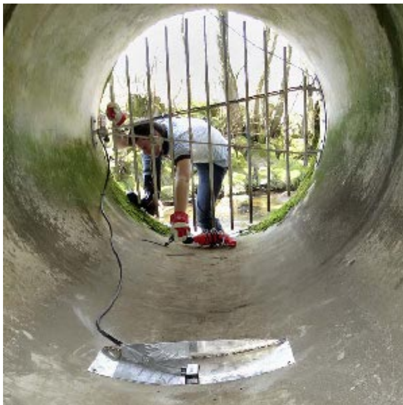
Probenahme im Überlaufkanal des Regenbeckens.
