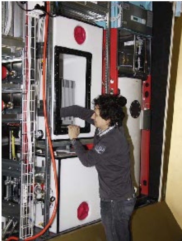
Links: Montage der Kleinkläranlage über dem Brauchwasserspeicher im engen Technikraum des Wohncontainers Self. Mitte: Membranmodul für die Trinkwasseraufbereitung aus Dach- bzw. Regenwasser. Rechts: Membranmodul für das Grauwasserrecycling.
