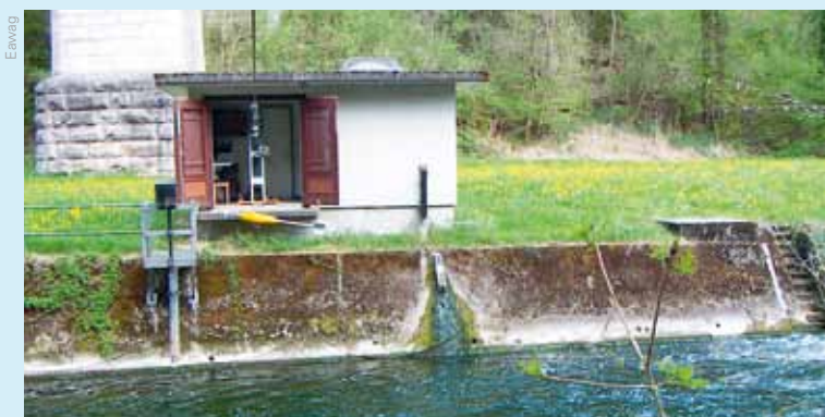
Station de mesure sur la Glatt à Rheinsfelden.
