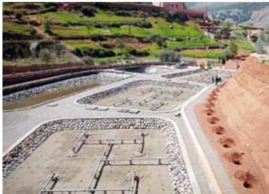
Installation de traitement des eaux usées près de Marrakech. Auparavant, les effluents de près de 1200 personnes se déversaient directement dans les champs et dans le cours d'eau voisin.
