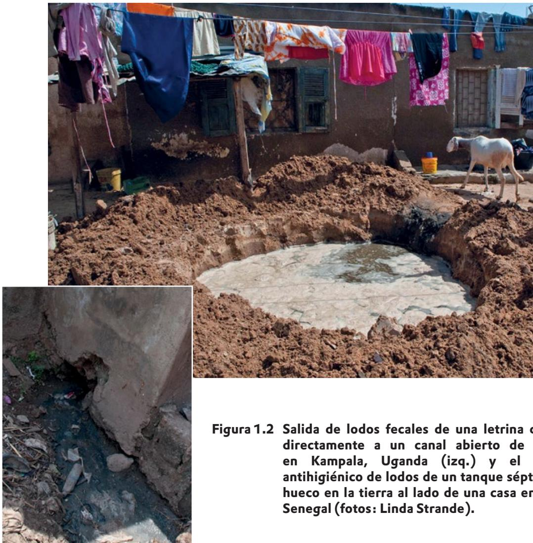
**Figura 1.2 Salida de lodos fecales de una letrina de pozo directamente a un canal abierto de drenaje en Kampala, Uganda (izq.) y el vaciado antihigiénico de lodos de un tanque séptico a un hueco en la tierra al lado de una casa en Dakar, Senegal (fotos: Linda Strande).**
