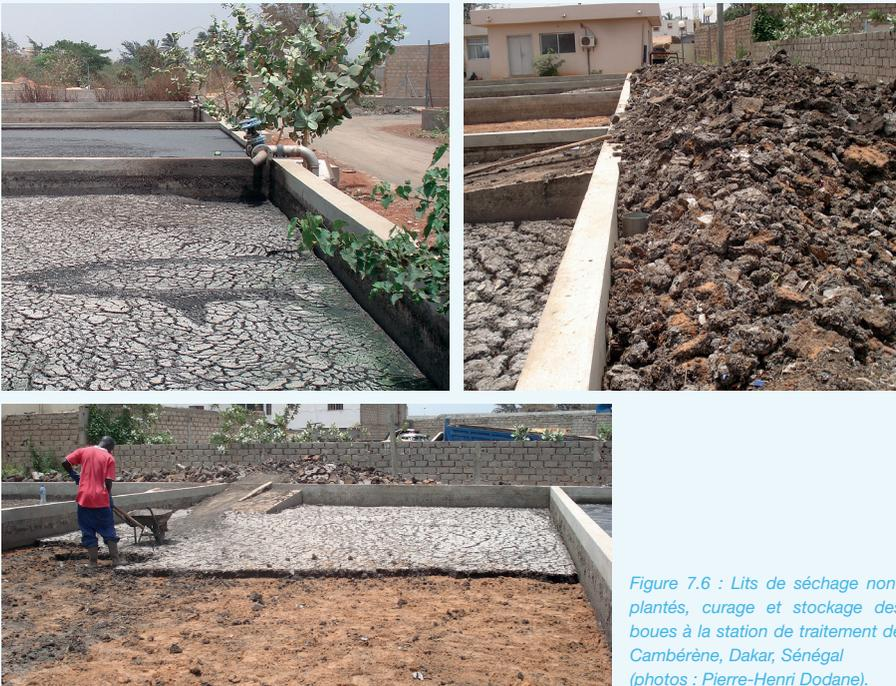
Figure 7.6 : Lits de séchage non-plantés, curage et stockage des boues à la station de traitement de Cambéréne, Dakar, Sénégal (photos : Pierre-Henri Dodane).
