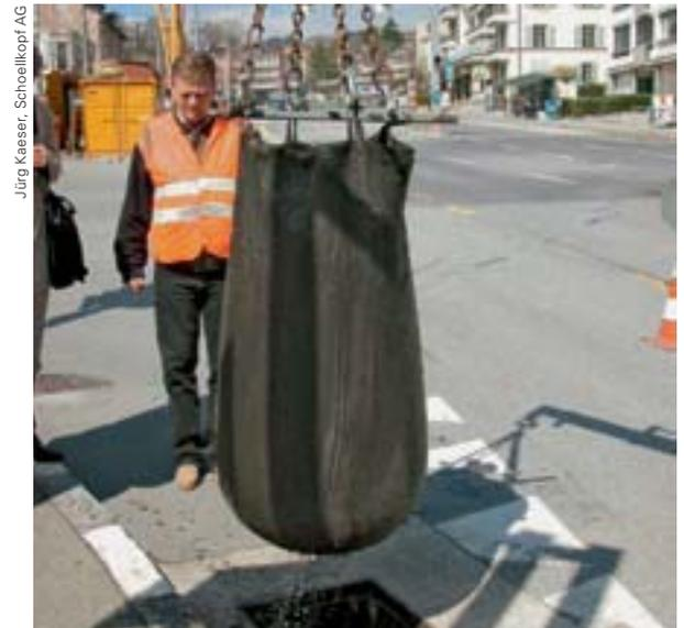
Wechsel eines mit Strassenschlamm gefüllten Filtersacks in Pully/VD.
