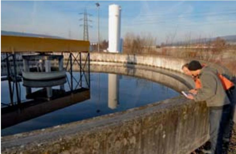
ARA Regensdorf: Im Hintergrund der Tank mit dem Flüssigsauerstoff zur Ozonproduktion.
