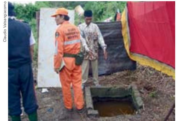
Zerstörter Trinkwasserbrunnen bei Aceh, Indonesien, welcher zur Instandstellung in Betracht gezogen wurde. Hinter der schwarzen Plastikplane befindet sich eine Grubenlatrine, die den Brunnen laufend verschmutzt.
