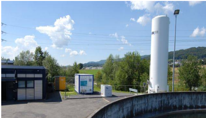
ARA Wüeri in Regensdorf
