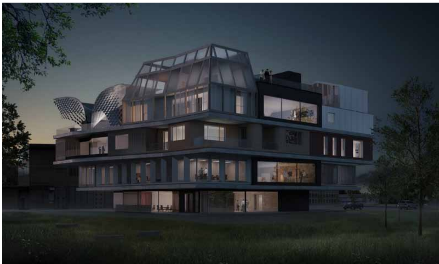
Fig. 1: Le bâtiment expérimental NEST est occupé en permanence pour l'hébergement des personnes en visite et ses bureaux sont utilisés au quotidien. Lorsqu'un projet de recherche est terminé, le module d'habitation concerné est enlevé du bâtiment et remplacé par un autre.
