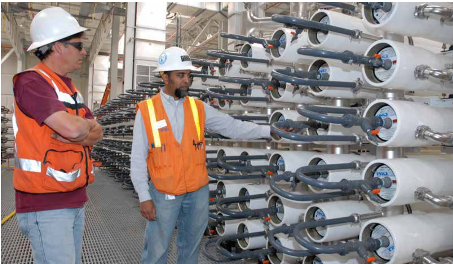
Abb. 1: Der kalifornische Wasserversorger «Orange County Water District» bereitet Abwasser zu Trinkwasser auf. Im Gegensatz zu anderen solchen Vorhaben im Bundesstaat stiess dieses Projekt nicht auf öffentlichen Widerstand. Im Bild die Umkehrosmose-Anlage.
