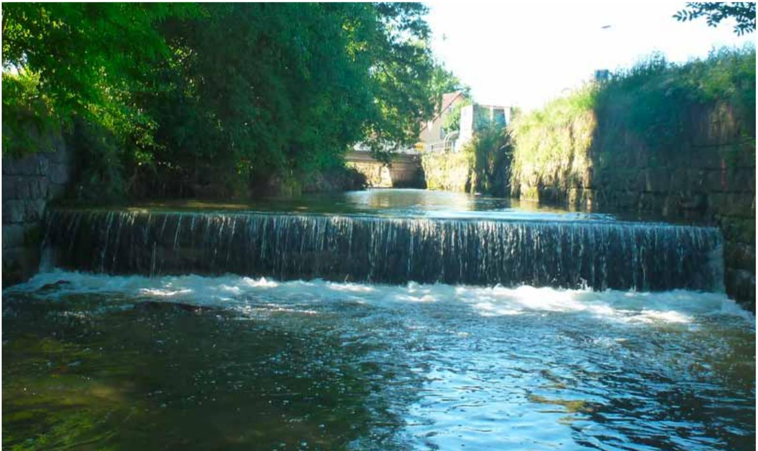
Fig. 1: Les chutes et seuils artificiels constituent des obstacles infranchissables pour les poissons: barrage sur l'Aabach à Uster (ZH)
