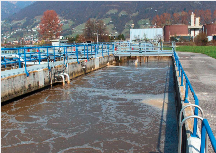
Fig. 14 Die Kläranlage Focé Ticino bei Gordola verfügt zur Stickstoffelimination über eine Nitrifikation mit vorgeschalteter Denitrifikation: Bei den Stickstofffrachten aus ARA im Einzugsgebiet des Langensees besteht noch ein erhebliches Optimierungspotenzial La station d'épuration Focé Ticino près de Gordola dispose d'une nitrification avec dénitrification en amont pour l'élimination de l'azote: pour les charges en azote des STEP dans le bassin versant du Lac Majeur, il y a d'importantes possibilités d'amélioration (Foto: H. Siegrist, Eawag)
