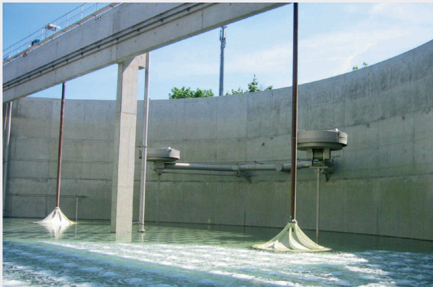
Fig. 2 Die ARA Birs in Birsfelden (BL) ist 2007 umfassend erneuert und ausgebaut worden. Mit ihren fünf SBR-Reaktoren zur weitergehenden Stickstoffentfernung gehört sie europaweit zu den grössten Kläranlagen, welche diese Technologie nutzen
