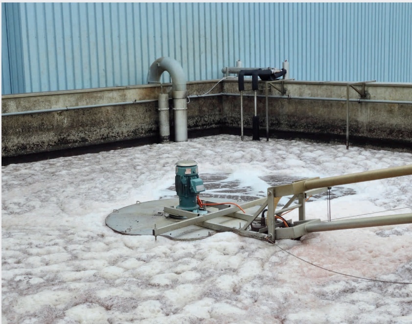
Fig. 11 In der ARA Glarnerland wird der Stickstoff aus der Faulwasserbehandlung in einem offenen Anammox-Reaktor abgebaut. Bei optimalen Betriebsbedingungen ermöglicht die Oxidation von Ammonium und Nitrit zu molekularem Stickstoff eine zusätzliche Eliminationsleistung, die etwa 15% des im Abwasser zufließenden Stickstoffs entspricht Dans la STEP Glarnerland, l'azote issu du traitement des eaux putrides est éliminé dans un réacteur Anammox ouvert. Dans des conditions d'exploitation optimales, l'oxydation de l'ammonium et du nitrite pour former de l'azote moléculaire permet des performances d'élimination supplémentaires correspondant à env. 15% de l'azote arrivant avec les eaux usées (Fotos: A. Joss, Eawag)
