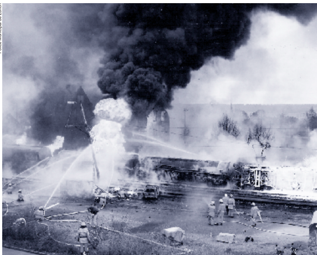
Fig. 2: Après l'accident du train-citerne survenu en 1994 à Zurich Affoltern, env. 5 tonnes de MTBE ont contaminé le sous-sol par infiltration d'essence.
