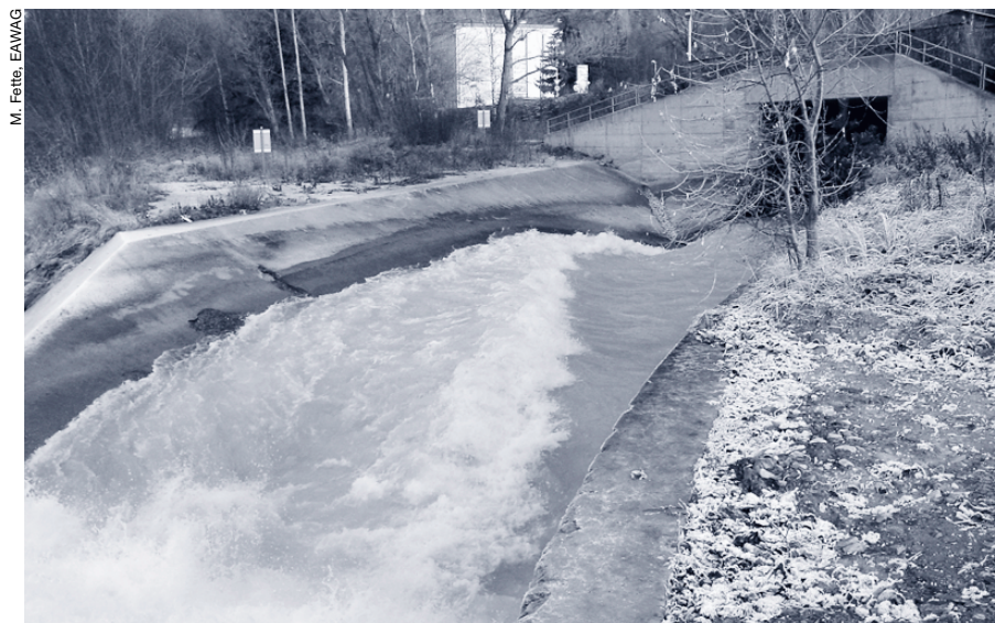
La restitution des eaux turbinées provoque l'effet du marnage.
