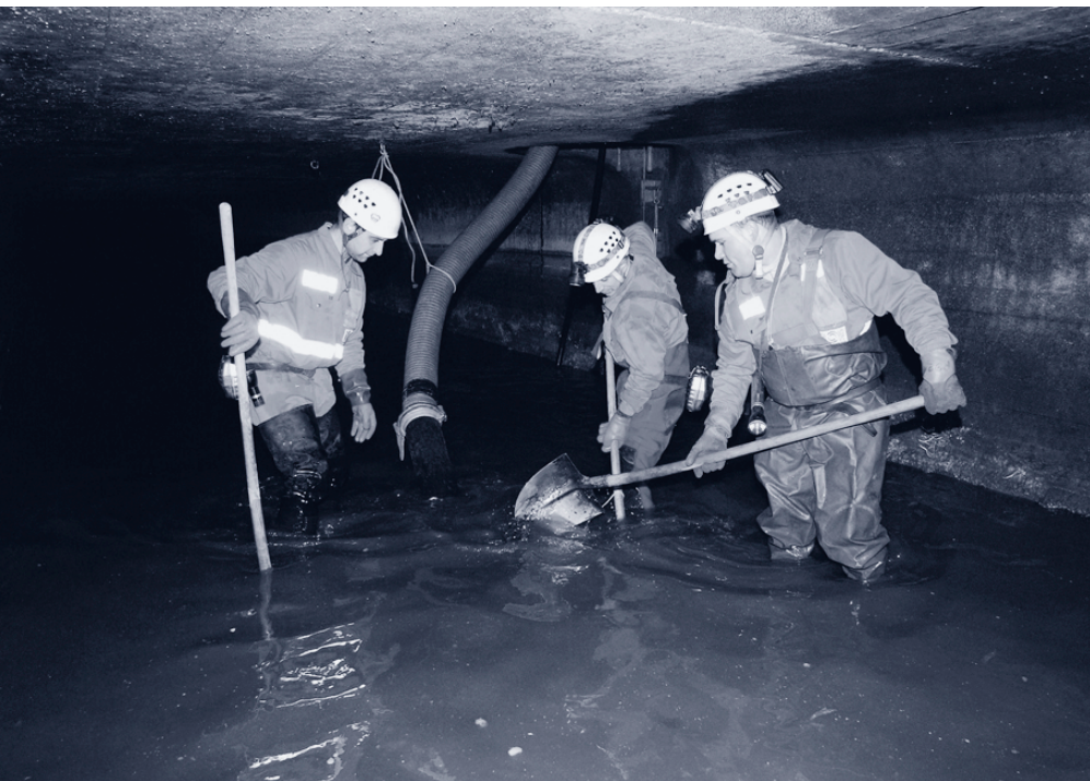
Wartungsarbeiten in der Kanalisation durch Mitarbeiter von Entsorgung + Recycling Zürich.
