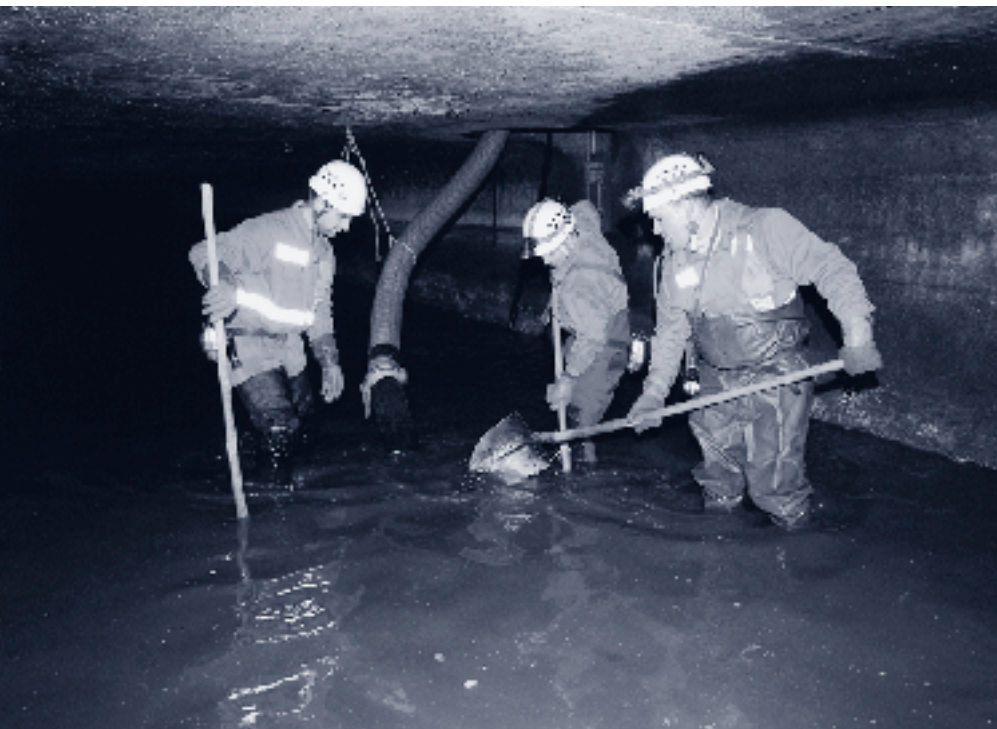
Travaux d'entretien dans les égouts effectués par des employés de «Entsorgung + Recycling Zürich».
