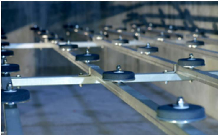
**Die Ozonung ist eine bewährte Methode, um Spurenstoffe aus dem Wasser zu entfernen. Im Bild: Ozon-Diffusoren in der ARA Neugut in Dübendorf.
