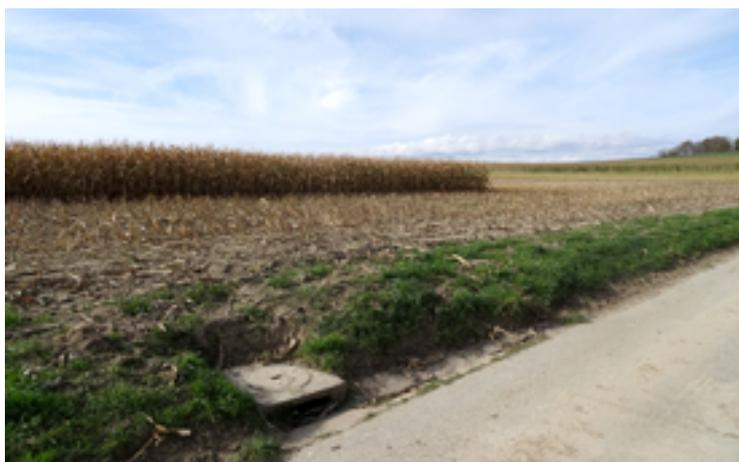
**Über solche Einlaufschächte gelangt Wasser vom Feld und vom Flurweg direkt ins nächste Gewässer – ein hydraulischer Kurzschluss.**
