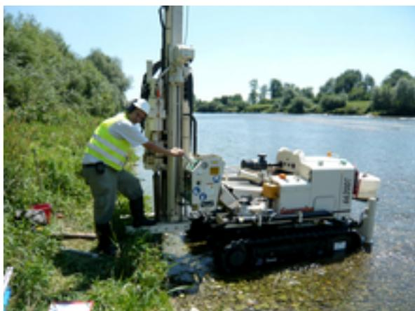
Installation eines Grundwasserbeobachtungsrohrs (Piezometer) an einem revitalisierten Abschnitt der Thur mit dem Rammgerät Geoprobe.
