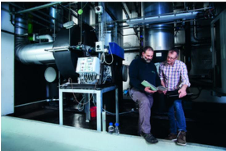
*Luftstrippungsanlage zur Stickstoff-Rückgewinnung auf der Kläranlage Opfikon.
