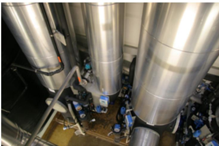
*Luftstrippungsanlage zur Stickstoff-Rückgewinnung auf der Kläranlage Opfikon. (Foto: Eawag,*
