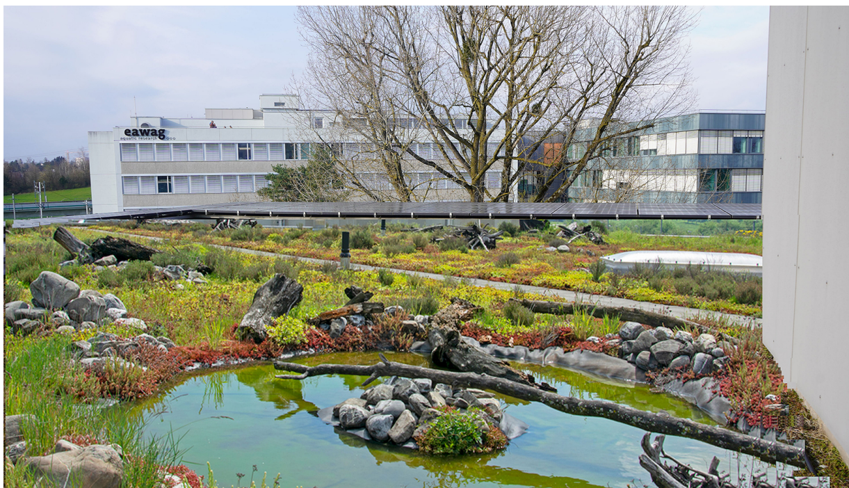
Biotop, Wasserrückhalt und Energiespeicher in einem: Pilotanlage auf dem Dach der Eawag (Foto: Eawag).
