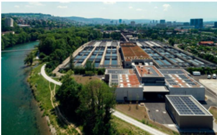
Abwasserreinigungsanlagen (im Bild die ARA Werdhölzli) haben ein grosses Potenzial zur Energierückgewinnung. Die aus dem gereinigten Abwasser entnommene Wärme wird ein Fernwärmenetz eingespeist.
