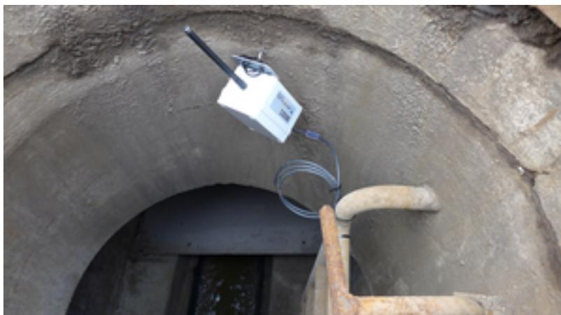
*Pegelsensor im Abwasserkanal mit Funkübertragung
