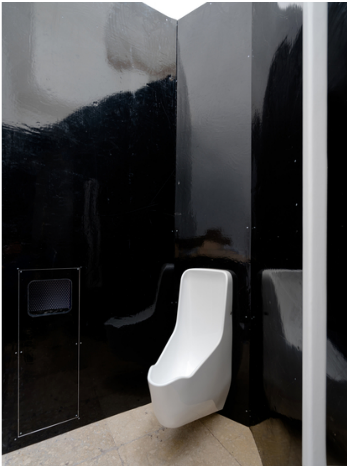
Der «Waschraum» des deutschen Pavillons mit Trockentrenntoilette (Bild links) und Urinal (Bild rechts) (Fotos: ARCH+ SUMMACUMMFEMMER BÜRO JULIANE GREB)
