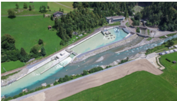
Ein Beruhigungsbecken reduziert negative ökologische Effekte der schwallweisen Wasserrückgabe durch die Wasserkraftnutzung in die Aare bei Innertkirchen. (Foto: Markus Zeh)
