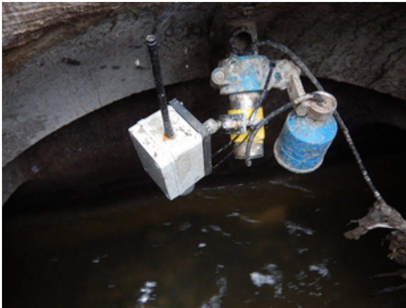
Abb.2.: Die Funksensoren liefern den Forschenden räumlich und zeitlich hochaufgelöste Messungen von Abflüssen und Pegelständen.
