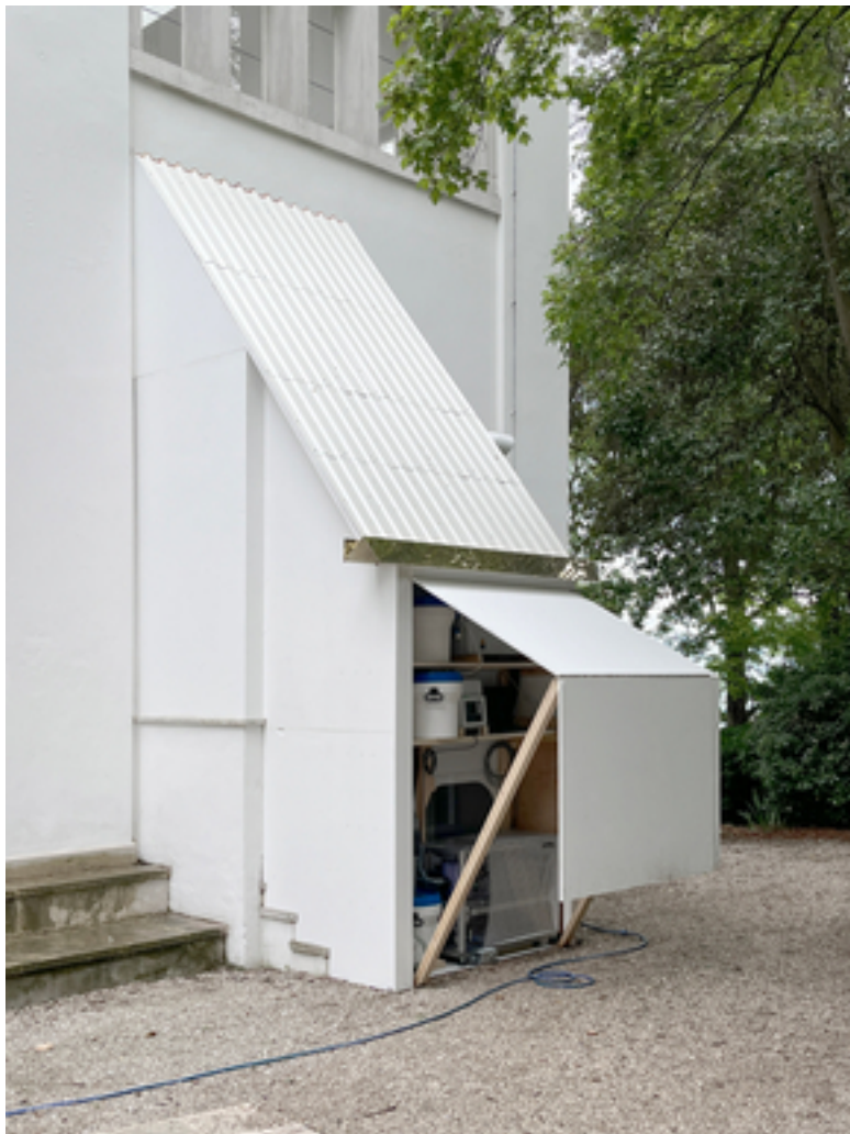
Der Nutrient Harvester gewinnt aus 30 Litern Urin rund 1 Kilogramm Trockendünger. (Foto: ARCH+ SUMMACUMFEMMER BÜRO JULIANE GREB)
