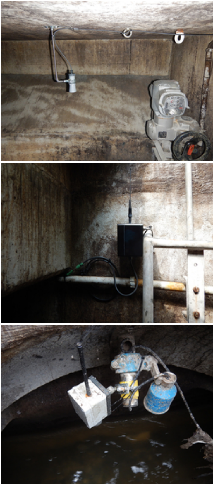
Abb.2.: Die Funksensoren liefern den Forschenden räumlich und zeitlich hochaufgelöste Messungen von Abflüssen und Pegelständen.
