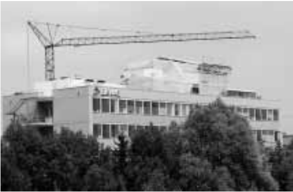
Abbildung: Notdach auf dem Laborgebäude während des Baus der Wärmerückgewinnungsanlage. (Foto: Herbert Güttinger)
