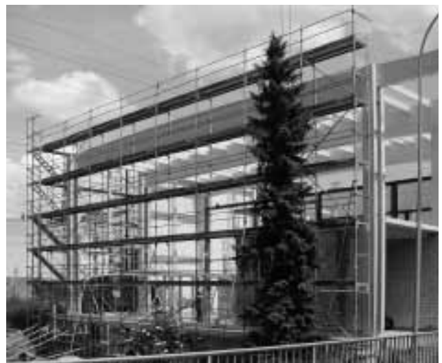
Abbildung 2: Der Holzbau der Versuchshalle ist im Entstehen; vom gleichen Standort wie Abbildung 1. (Foto: Raoul Schaffner)
