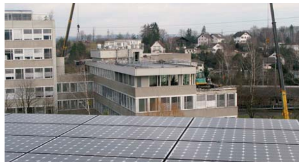
Die Solarpanel auf dem Dach des Forums Chriesbach. Nach Abschluss von Sanierung und Aufstockung des alten Bürogebäudes (hinten) soll auch dort auf dem Dach eine Fotovoltaikanlage installiert werden.
