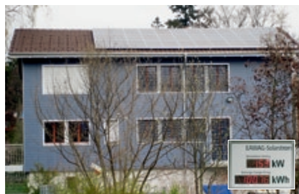
Die Fotovoltaikanlage auf dem renovierten Bootshaus in Kastanienbaum hat bereits mehr als 10000 kWh Strom geliefert. Sie wurde mit CO 2 -Abgaben aus Flugreisen finanziert.
