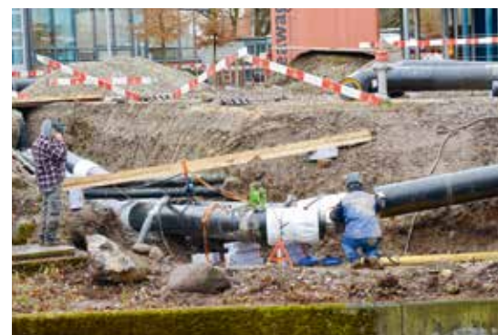
Pose de nouvelles conduites pour le réseau de chaleur basse température du site Eawag-Empa.
