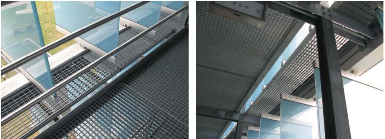
**Abbildung 6-29:** Anordnung der Gitterroste: linkes Bild von oben (links Normalstellung, rechts gedreht), rechtes Bild von unten in gedrehter Stellung (Eawag)
