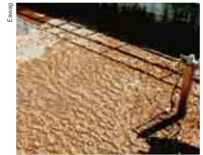
Die zähen Schäume auf den Becken der Kläranlagen enthalten eine hohe Konzentration an aufschwimmender Biomasse.
