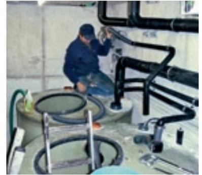
Montage der Anlage in engen Verhältnissen. Anstelle der Klärtanks hingen hier früher Plastiksäcke, in welchen die Fäkalien ins Tal gebracht werden mussten.
