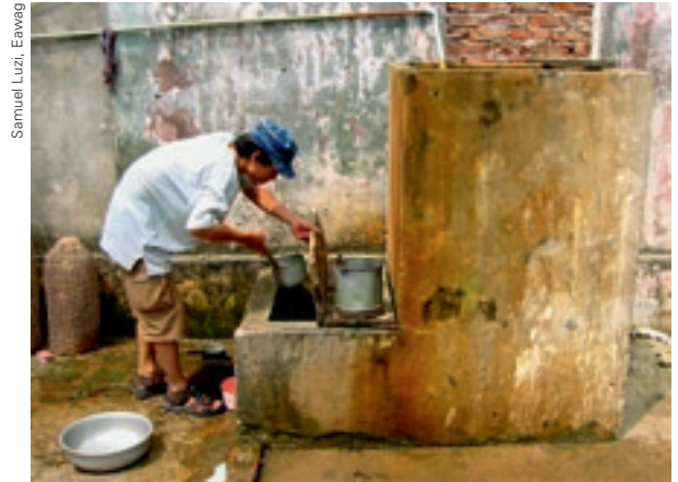
Sandfilter zur Eisen- und Arsenentfernung in ländlichen Haushalten im Delta des Roten Flusses, Vietnam.
