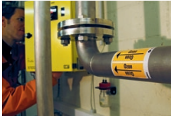
Die Ozonierung des bereits gereinigten Abwassers kann 90 % der verbliebenen Toxizität reduzieren.
