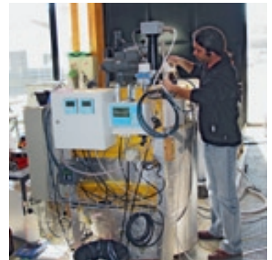
Der 400-Liter-SBR-Reaktor für das Anammox-Verfahren in der Eawag-Versuchshalle.
