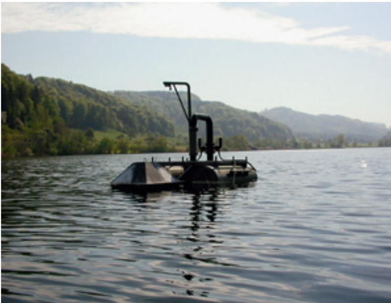
Die Anlage zur Zirkulationsunterstützung im Türlensee sorgt für eine Durchmischung und einen höheren Sauerstoffgehalt in den tiefen Wasserschichten.
