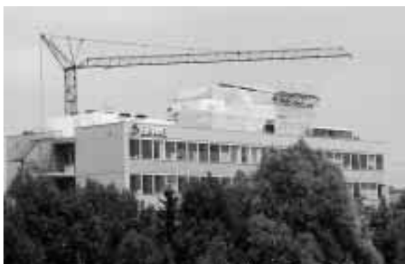
Abbildung: Notdach auf dem Laborgebäude während des Baus der Wärmerückgewinnungsanlage. (Foto: Herbert Güttinger)
