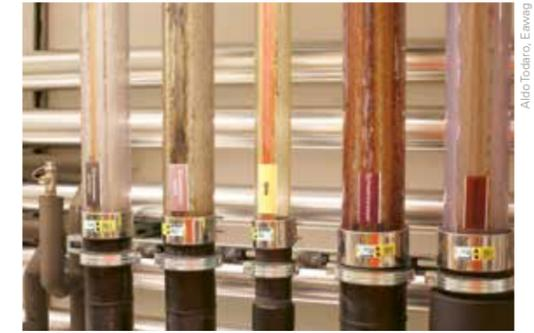
Indem man die Abwasserströme schon an der Quelle separiert, kann man diese einzeln aufbereiten. Hier werden Grauwasser, Schwarzwasser und Urin getrennt.
