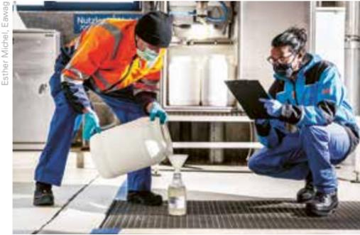
Ein Teil der Abwasser-Sammelprobe kommt von der Kläranlage ins Labor zur Analyse.
