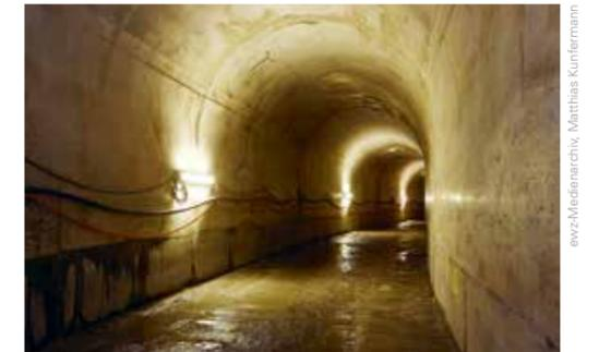
À Tiefencastel (GR), une galerie de dérivation mise en service en 2012 permet de transporter les sédiments vers l'aval en cas de crue afin d'éviter qu'ils ne s'accumulent dans la retenue de Solis.
