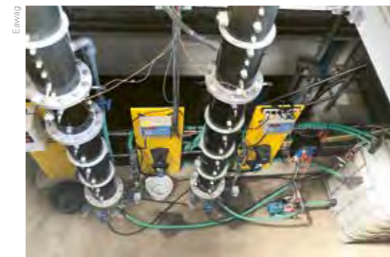
Essais pilotes de filtration sur CAG à la STEP de Muri
