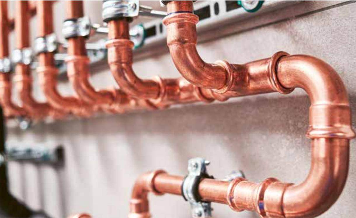
**Photo** À une température comprise entre 35 °C et 40 °C, les légionelles peuvent se multiplier dans les réseaux d'eau potable des bâtiments.
