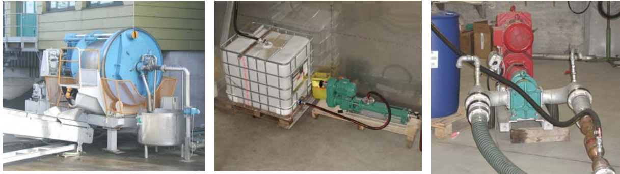
Figur 8: HP2500 zwischen Faultürmen und Schlammagerplatz der ARA Glarnerland (linkes Bild, vor der Presse das Förderband; FHM-Aufbereitungsstation mit FHM-Dosierpumpe (Mitte); Schlammpörderpumpe mit stat. Mischer (rechts))
