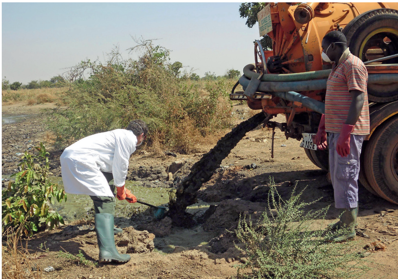
Figura 2.4 Campaña de muestreo para cuantificar y caracterizar los lodos fecales en Uagadugú, Burkina Faso, para el diseño de una nueva estación de tratamiento de lodos fecales. Ninguna existe actualmente en esa ciudad y la única opción para las compañías de recolección y tratamiento es la descarga directa en el ambiente (foto: Hanspeter Zoellig).
