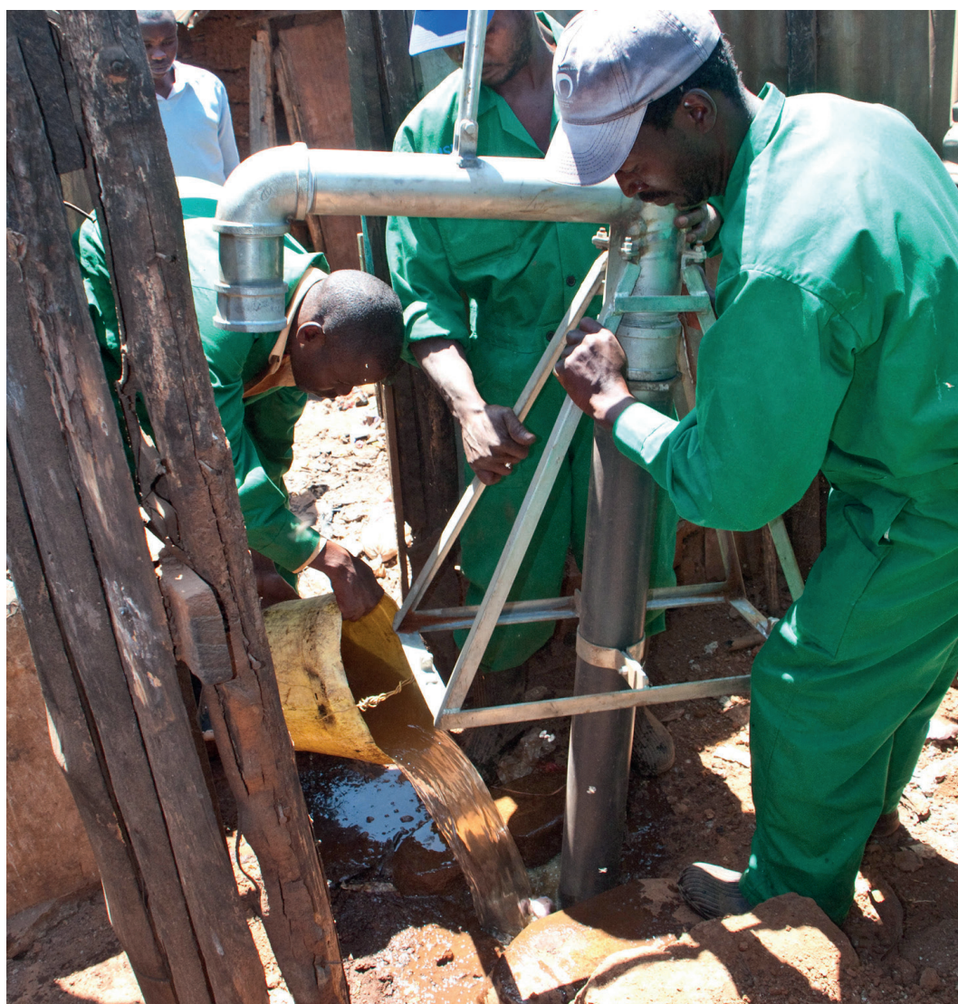
Figura 2.2 Agregación de agua para facilitar la recolección de los lodos fecales espesos en el fondo de una letrina de pozo, utilizando un “Tragón” (“Gulper”), en el asentamiento informal de Kibera, Nairobi, Kenia (foto: Linda Strande).
