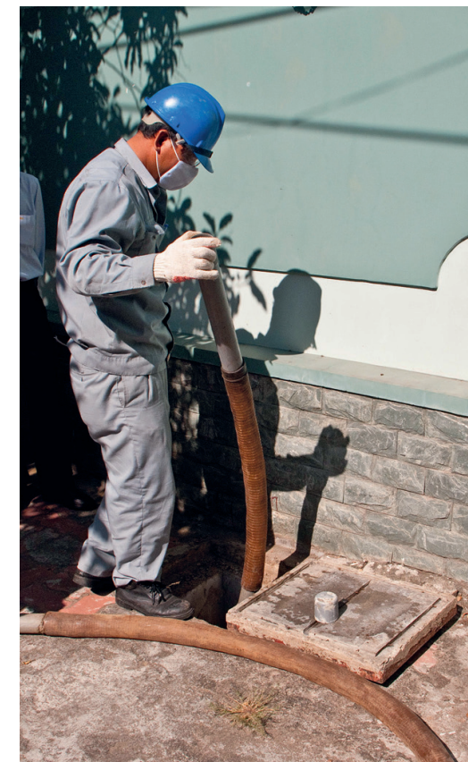
Figura 4.3 Ejemplo de un tanque séptico con la tapa bien diseñada para fácil acceso, en la provincia Vung Tau de Vietnam (foto: Linda Strande).
