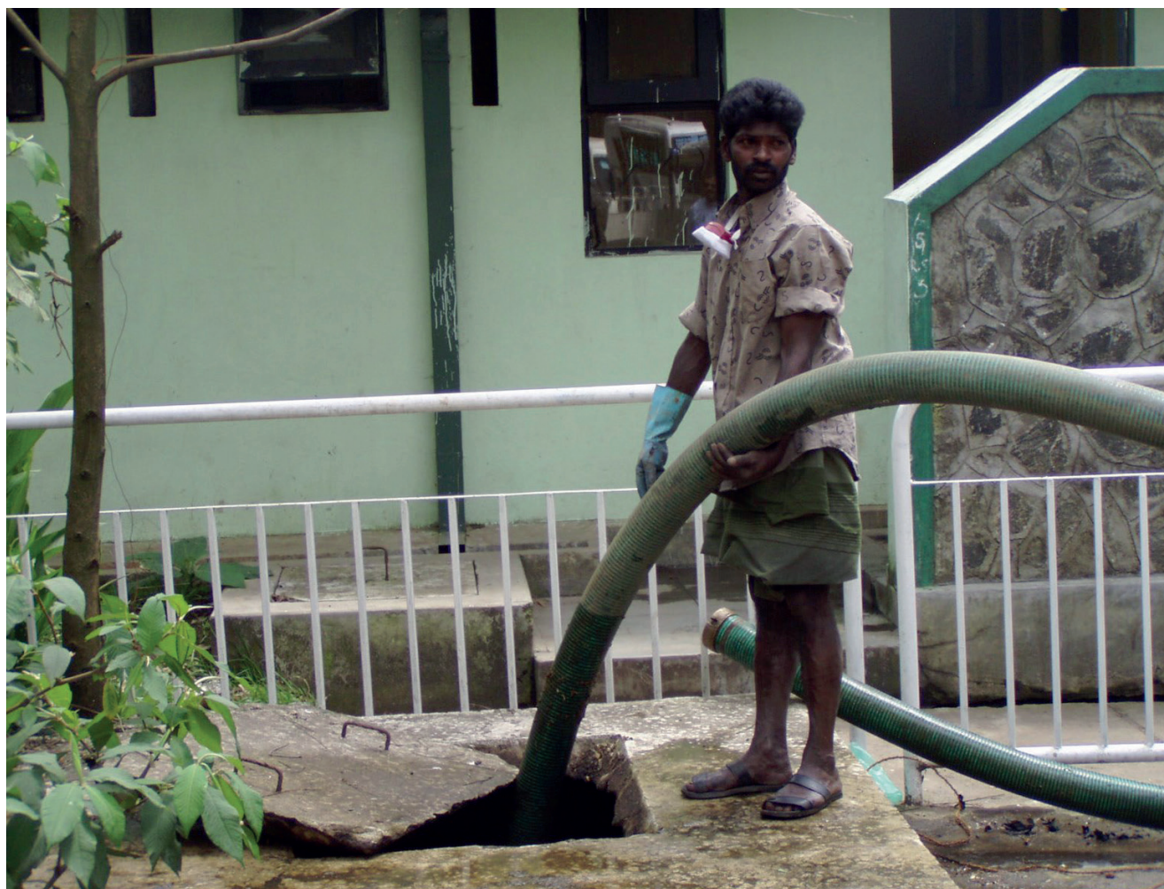
Figura 4.1 Vaciado de los lodos fecales de un tanque séptico con un equipo aspirador. La seguridad ocupacional podría mejorarse con la provisión y uso adecuado de los equipos de protección personal. (foto: David M. Robbins).
