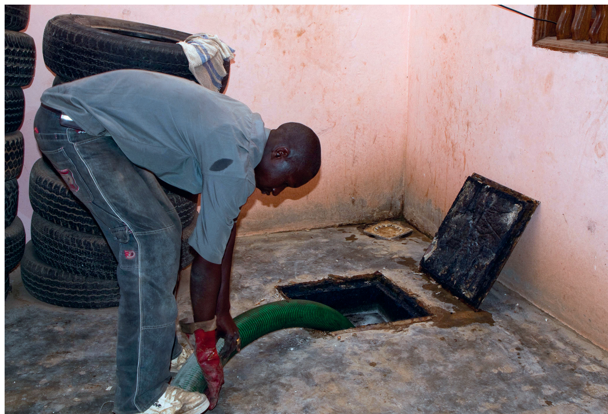
Figura 4.2 Ejemplo del vaciado de lodos fecales en Dakar, Senegal, con la estructura de contención ubicada en un patio interno donde hizo falta la cooperación de los residentes para el acceso (foto: Linda Strande).
