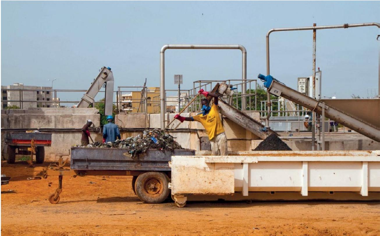
**Figura 11.1 Limpieza de los tamices en una estación de tratamiento de lodos fecales en Dakar, Senegal; esta actividad es imprescindible en cada turno para mantener el sistema operativo (foto: Linda Strande).**
