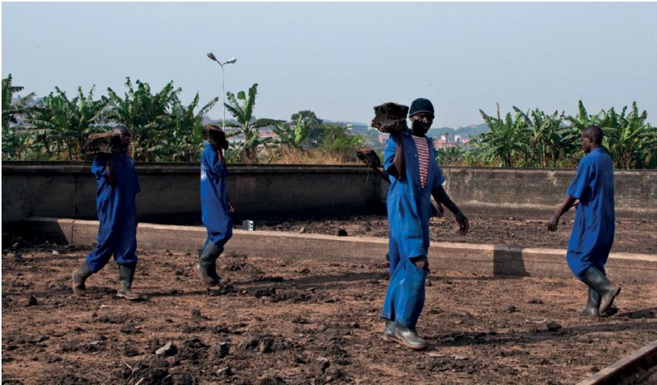
**Figura 11.7** Sacando el lodo de los lechos de secado en la Estación de Tratamiento Bugolobi en Kampala, Uganda (foto: Linda Strande).
