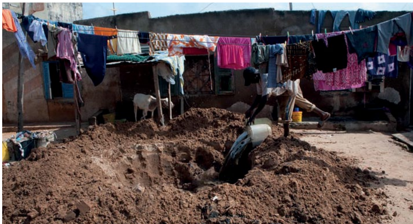
Figura 14.9 Vaciado manual de lodos fecales, enterrándose en el mismo patio de la casa (foto: Linda Strande).
