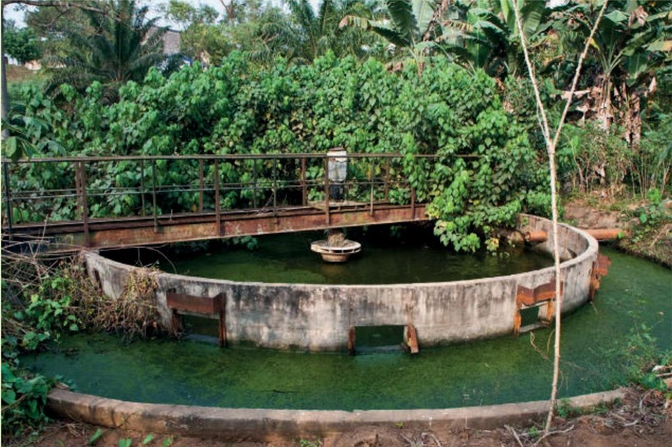
**Figura 17.3** Una estación depuradora de aguas residuales que ya no funciona en Yaoundé, Camerún (foto: Linda Strande).
